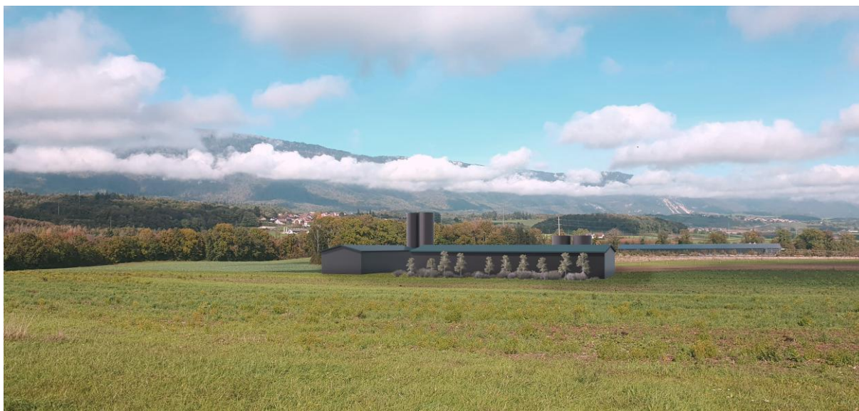
Fig.11 Vue du projet depuis la route cantonale
